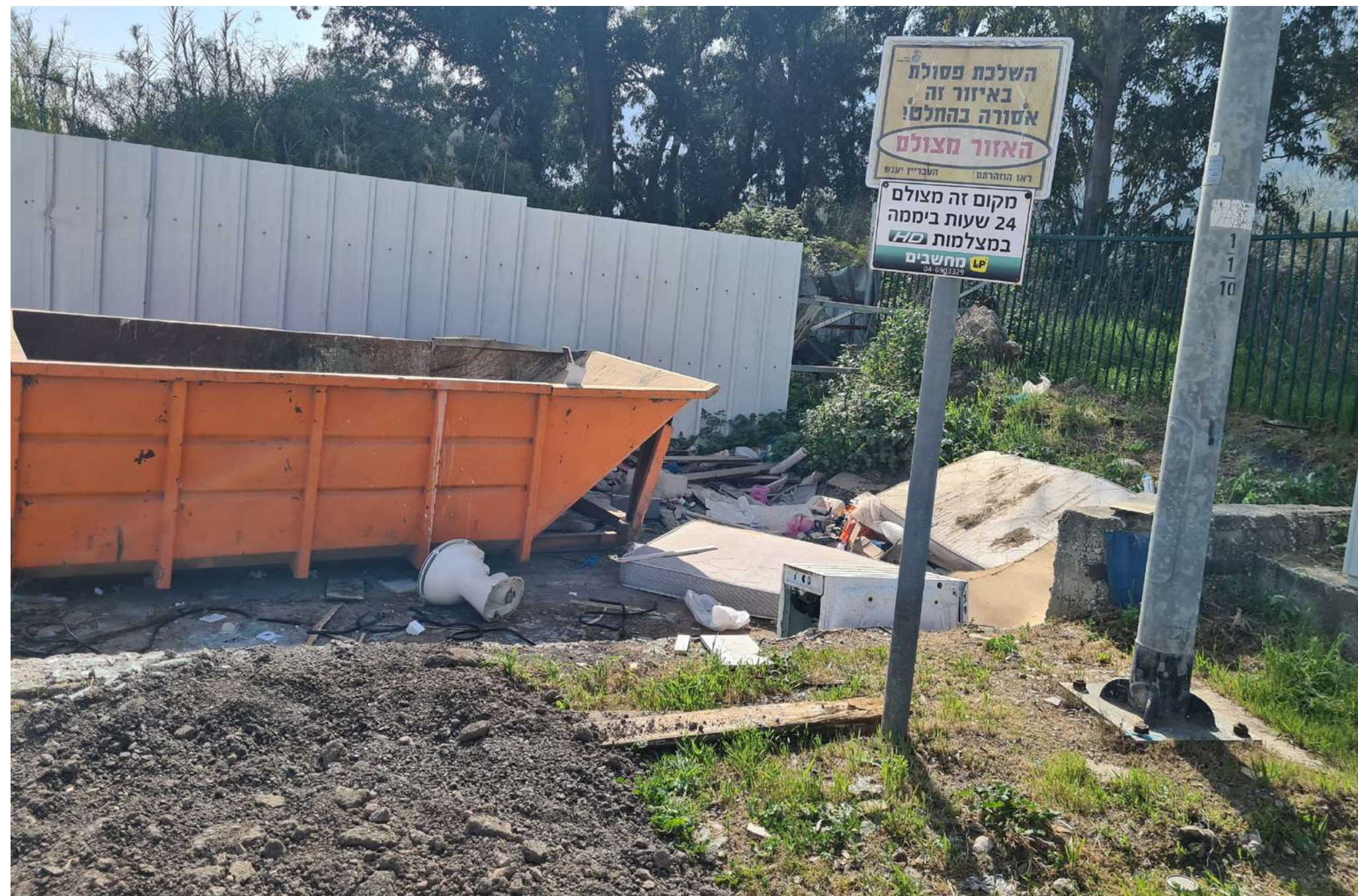
גידור מרחב הנחל ומצבורי בסולת בסמוך לנתיב הזרימה
